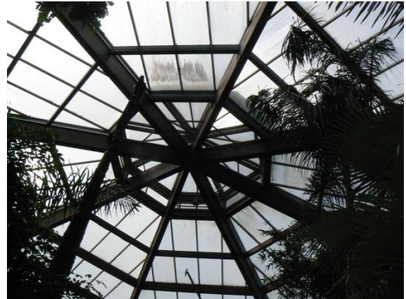
Bild 1: Stahlbaukonstruktion im Vogelpark Walsrode
